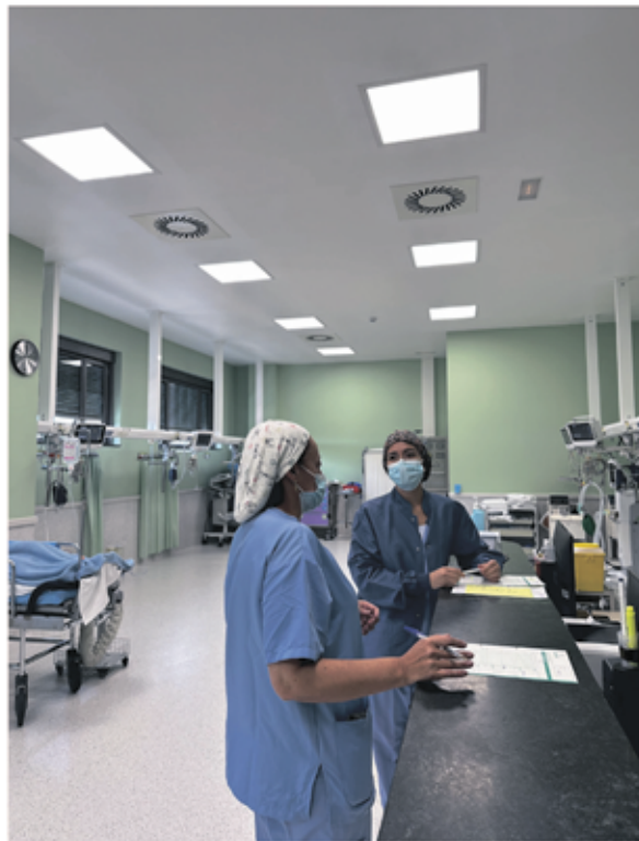
La nova il·luminaria LED a la sala de reanimació.
